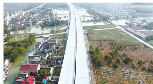
中亿丰基础设施承建苏州至台州高速公路七都至桃源段路桥工程 ST-QL5 标
