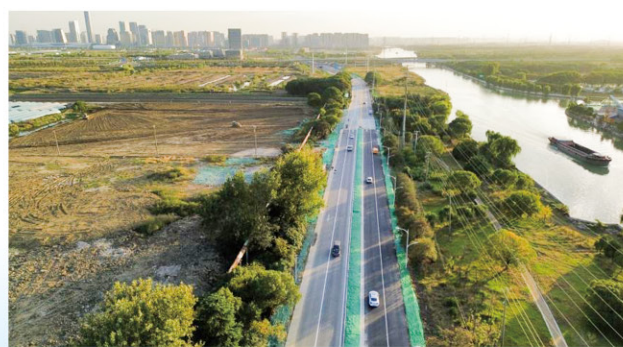
中亿丰基础设施承建相城大道（漕湖大道—朗力福大道）工程 XCDD-SG 标
